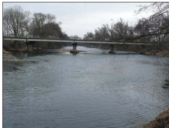
foto 2 Pohľad do koryta na dotknutý úsek z ľavého brehu proti prúdu
