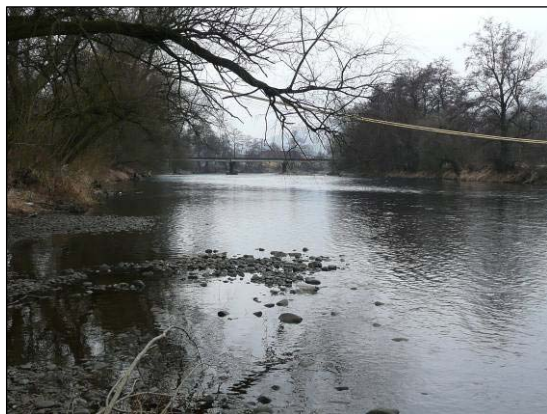
foto 1 Pohľad do koryta na dotknutý úsek z ľavého brehu po prúde
