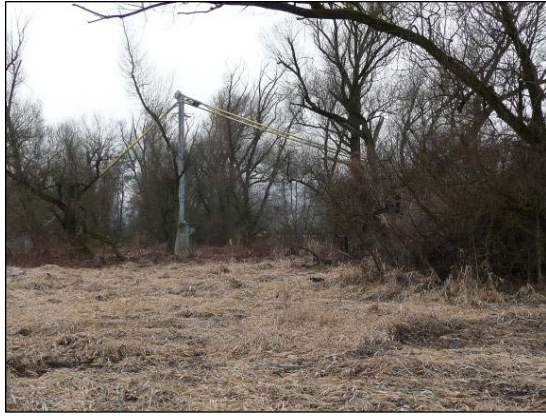
foto 3 Pohľad na ľavý breh – ľavobrežná podpera plynovodu
