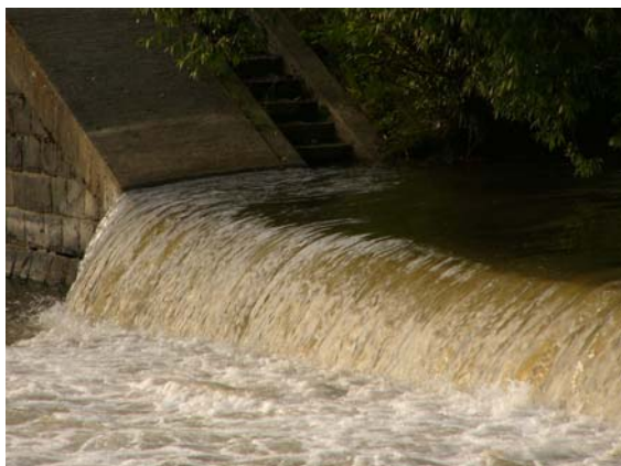
Prepadový lúč vodného stĺpca 1,2 m
